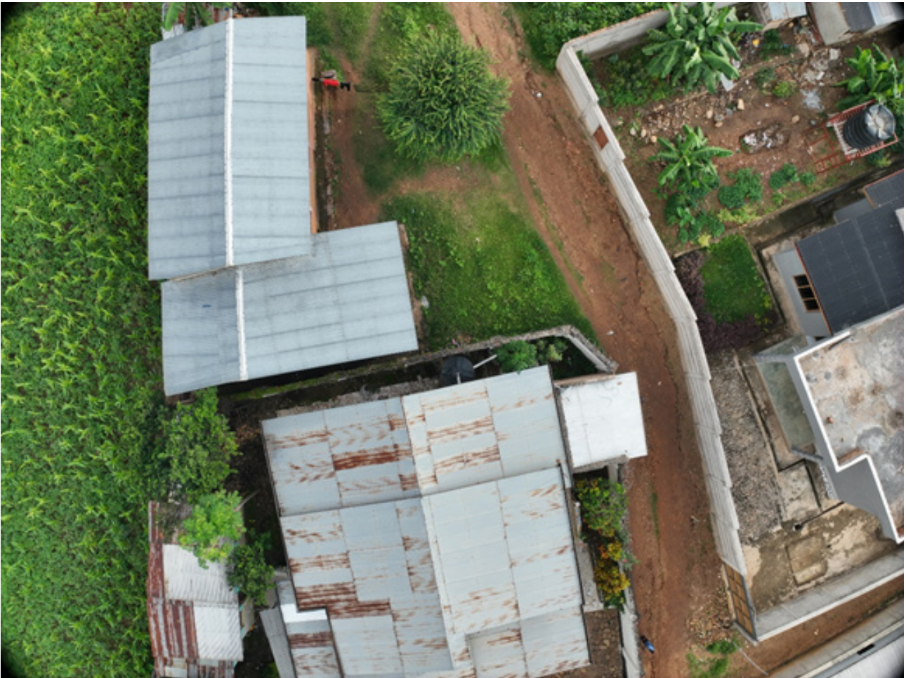
Figure 4. Photo montrant une piste et des parcelles dépourvues de système de canalisation d'eau qui finit par abîmer la piste en créant des rigoles.
