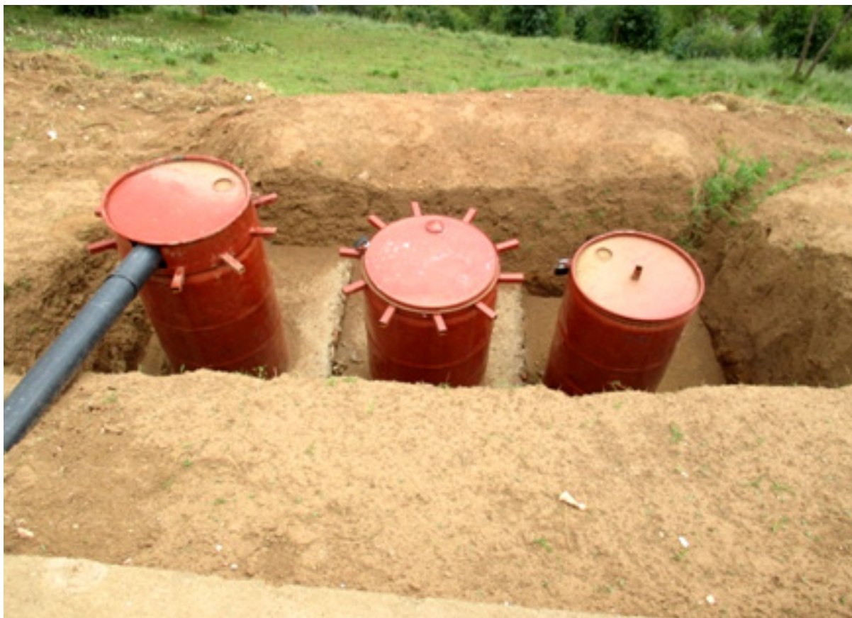
Figure 2. Système de collecte des pertes en terre et des eaux de ruissellement utilisé dans les expérimentations de Gashikanwa et Matongo.
